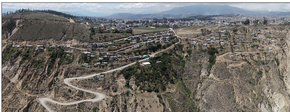
Figura 1. Vista frontal de la pendiente del barrio “Buenavista del Norte”
