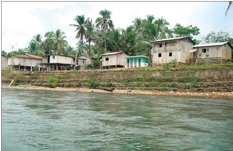
Imagen 4. Muro de contención en construcción, comunidad Playa de Oro
