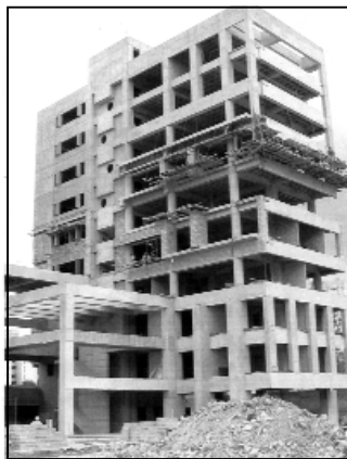
Avance de la obra a abril de 2004
