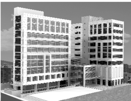
Vista general del proyecto
